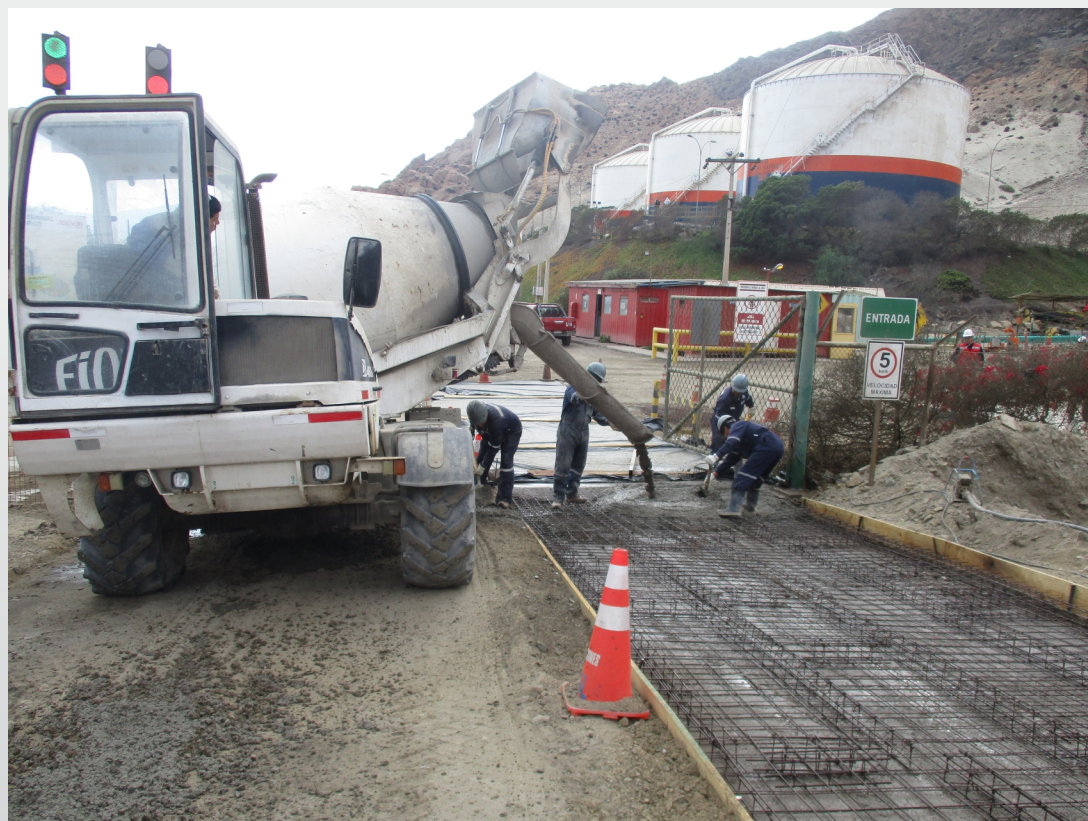
Pavimentación y trabajo de calzada Puerto de Barquito.
